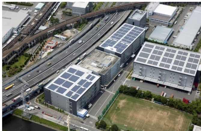
（参考1:太陽光パネル設置状況）
